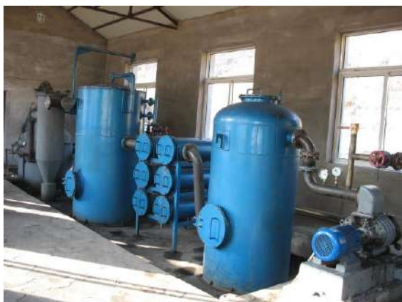
Рис. 4. Газогенераторна установка потужністю 200 кВт, що працює на рослинних залишках сільськогосподарського виробництва вологістю до 30 % (розробка Ліонінського інституту енергетичних ресурсів, КНР)
