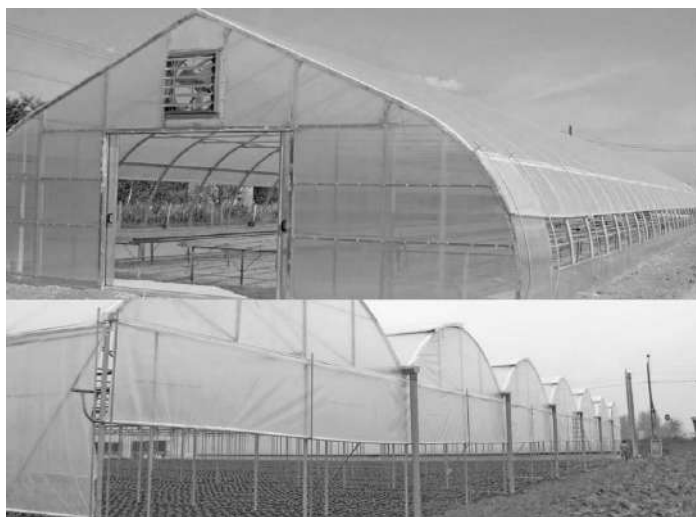
Рис. 2. Вентиляція через фронти конструкції теплиці
