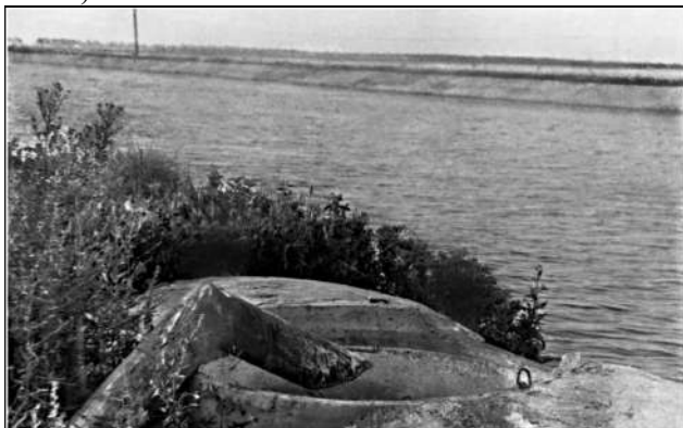
Рис. 4. Гирло напірного трубопроводу під час обстеження
